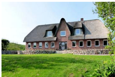
Großes Reetdachhaus mit 3 Wohnungen direkt am Deich
