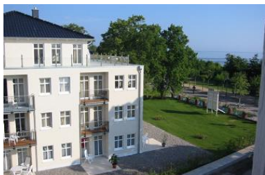
Hausansicht "Villa Aquamarina" von der Südseite (Nachbarhaus)
