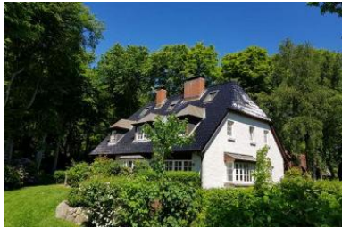
Das Haus Eulenkamp 8a.b und c rechts befindet sich das Haus a, ganz links das Haus c
