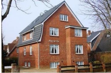
Das "Haus zur See" von außen.
