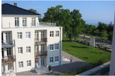
Hausansicht "Villa Aquamarina" von der Südseite
